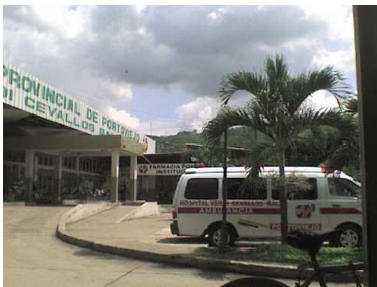
Instalaciones externas del Hospital Dr. Verdi Cevallos Balda en la ciudad de Portoviejo
