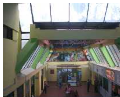
Fotografía 13: Ventanales en buen estado
