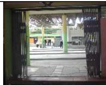
Fotografía 8: Rutas de salida, puertas se abren a los lados
