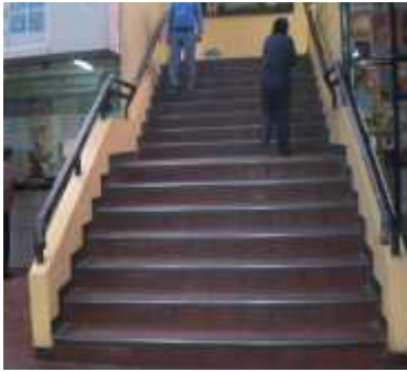
Fotografía N° 17: Escaleras despejadas, con barandas
