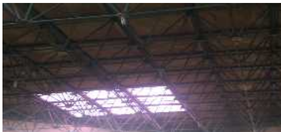
Fotografía 27: Estructura metálica, sin grietas, ni fisuras
