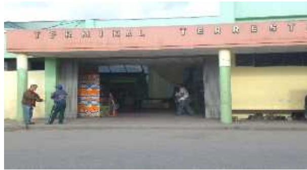
Fotografía N°18: Salidas amplias, no señalización
