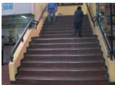
Fotografía 9: Escaleras despejadas, con barandas
