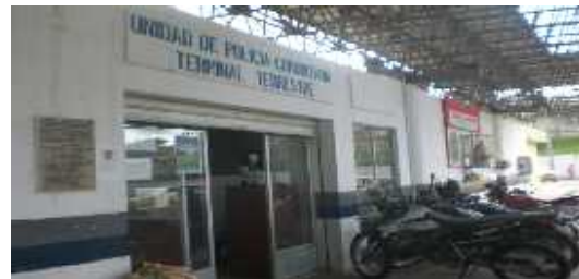
Fotografía N° 38: UPC en terminal para control
