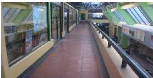
Fotografía 4: Pasillo libre de obstrucción
