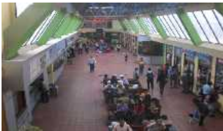
Fotografía N°31: No existen luces de emergencia a lo largo de pasillos de terminal
