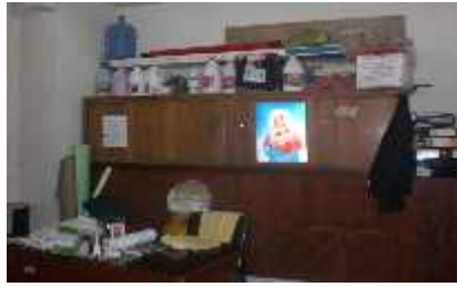
Fotografía 21: materiales sin anclaje
