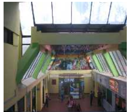
Fotografía N° 21: Ventanales en buen estado
