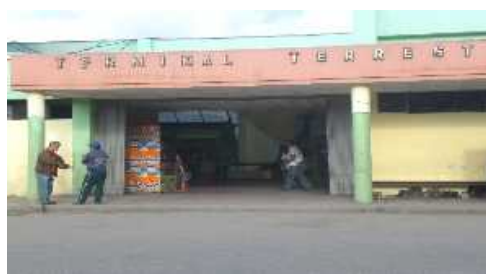
Fotografía 10: Salidas amplias, no señalización
