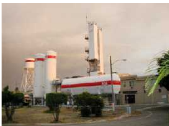
FIG. 13 – VISTA DE LA PLANTA DE GASES - GUAYAQUIL
