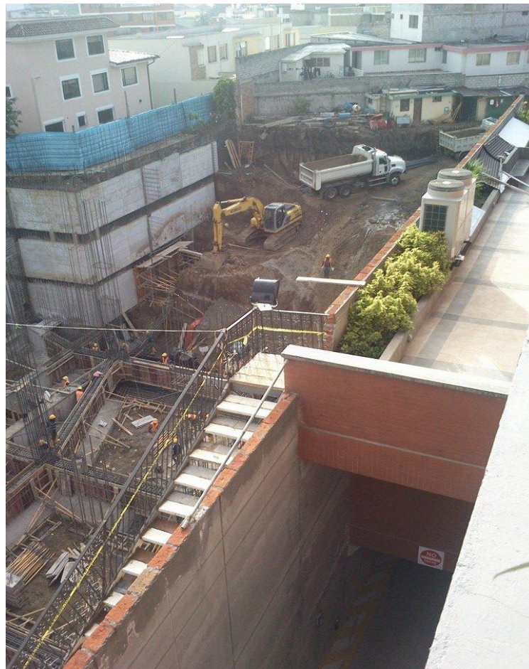
Imagen 3: Construcción edificio Eugenio Espejo
