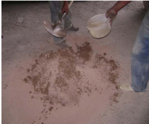
Fotografía N° 53. Momento en que se agrega el agua a la mezcla de materiales.
