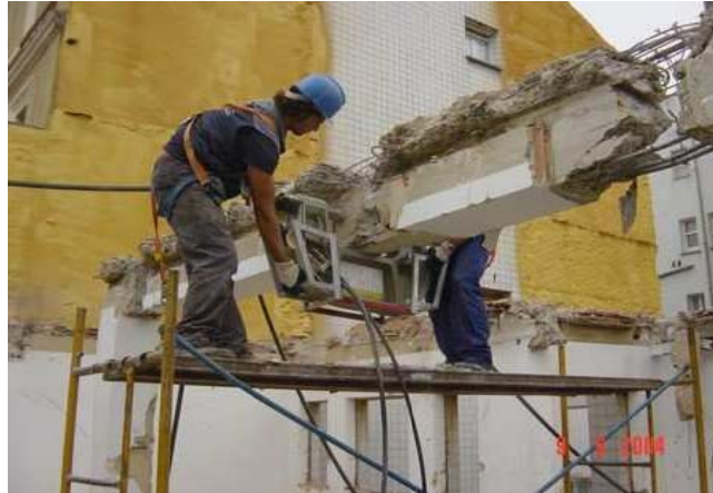
Fotografía Nº 4 Separación de los materiales.
