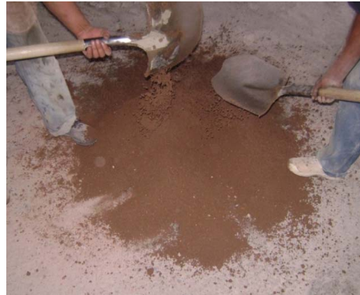
Fotografía N° 54. Batido del hormigón
