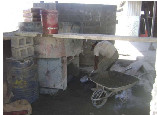
Fotografía N° 22 Recolección del material ya mezclado.
