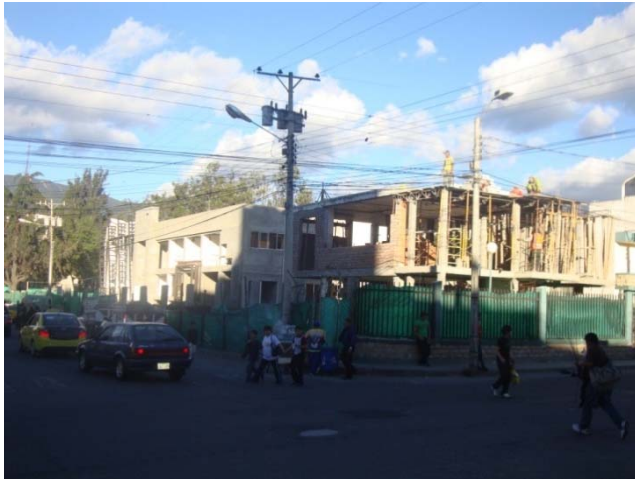
Fotografía N° 5 Remodelación del dispensario del IESS. Se generó alrededor de 1100 m3 de escombros
