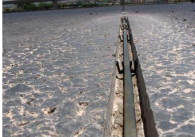
Figura 3.6. Sensor piezoeléctrico montado en su ranura, antes de ser recubierto.
