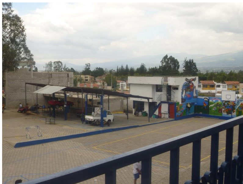
Vista de los talleres de Electromecánica Automotriz. Vista desde el segundo piso del edificio del Colegio Popular Particular Laico Latinoamericano.
