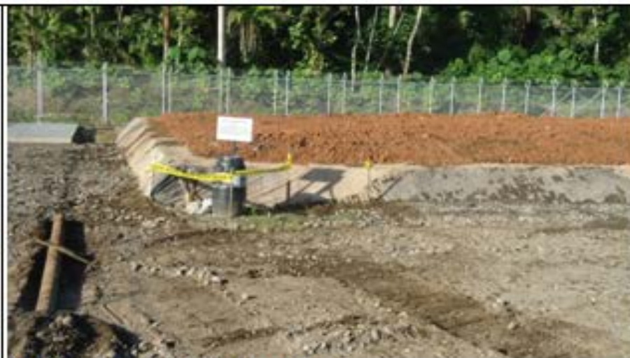
Foto 6: Tapado piscina de lodos de perforación
