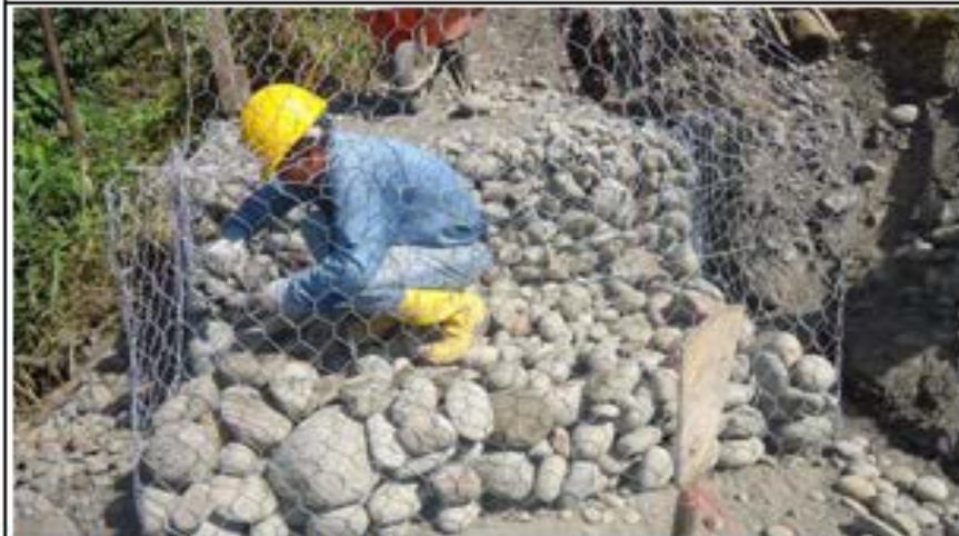
Foto 7: Construcción muro de gaviones
