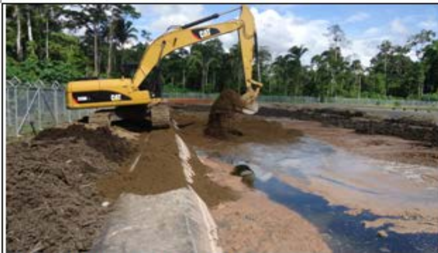
Foto 5: Tapado piscina de lodos de perforación
