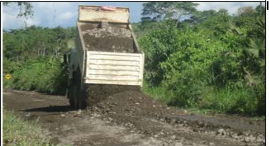
Foto 12: Construcción de vías
