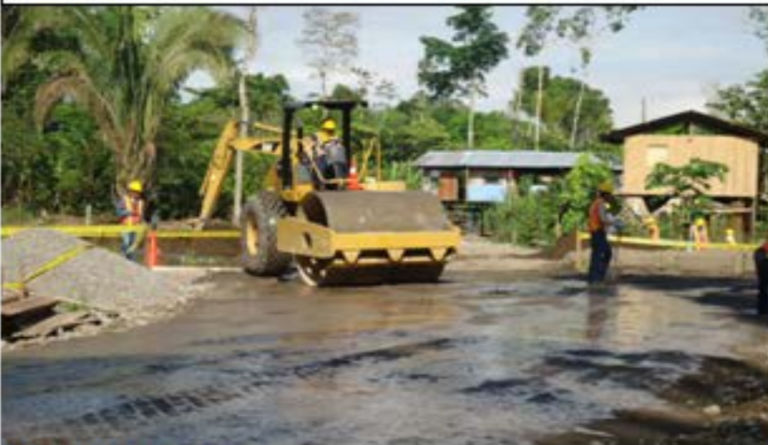
Foto 11: Construcción de vías
