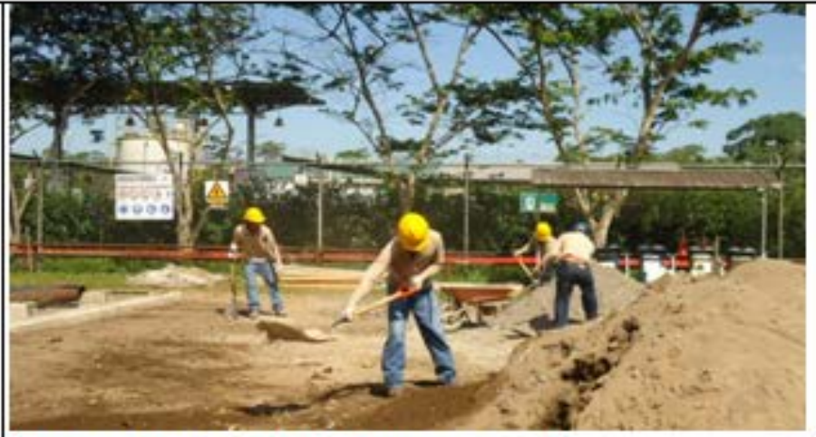
Foto 8: Preparación de material para el tapado de piscinas
