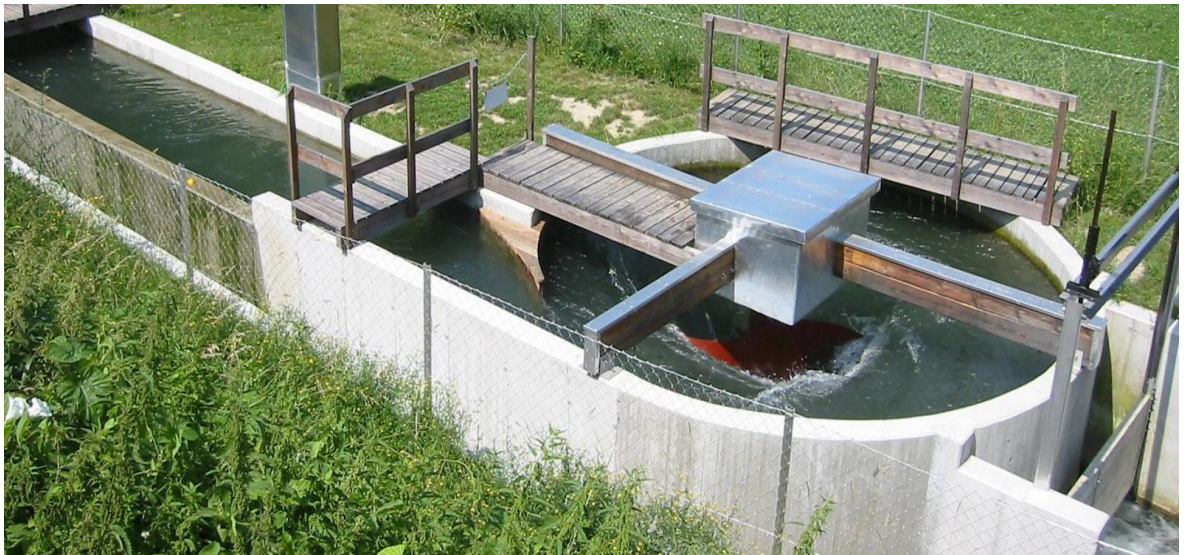
Figura 10. Planta energética de vórtice gravitacional hidráulico de Zotlöterer
