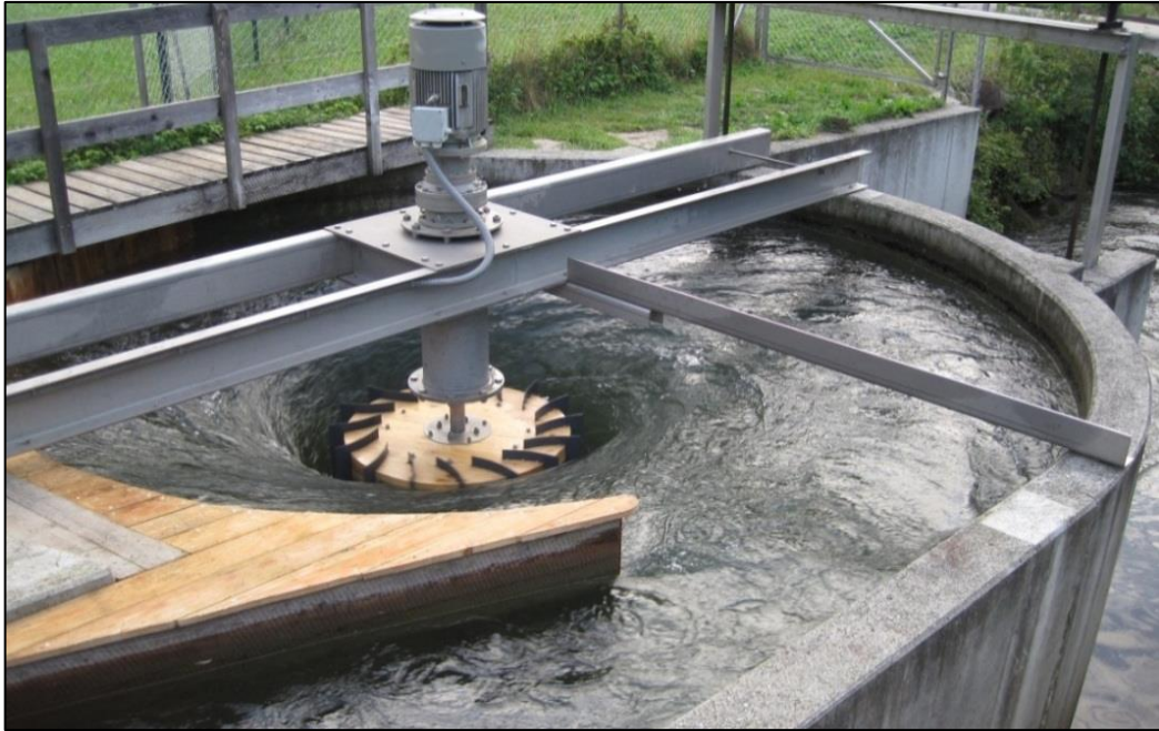
Figura 1. Planta energética de vórtice gravitacional hidráulico de Zotlöterer
