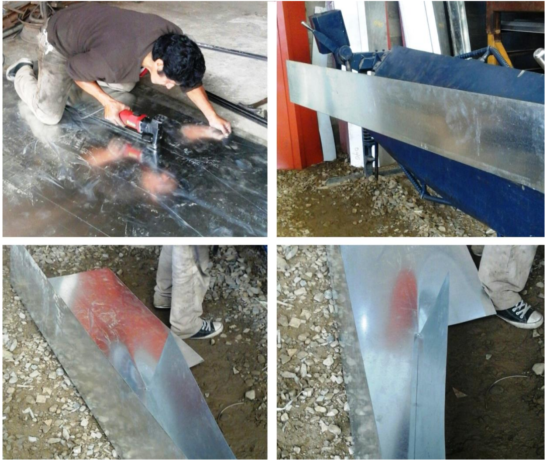
Figura 47. Corte y doblaje de canal de entrada
