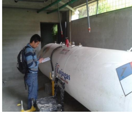
Figura 2.5. Bombona central de GLP. Fuente: Fotografía de los autores.
