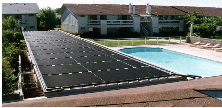
Figura 5.3. Foto de colectores de placa plana sin cubierta. Fuente: http://cer.gob.cl/tecnologias/solar/energia-solar%20termica-agua-caliente-sanitaria-ac/collectores-sin-cubierta/
