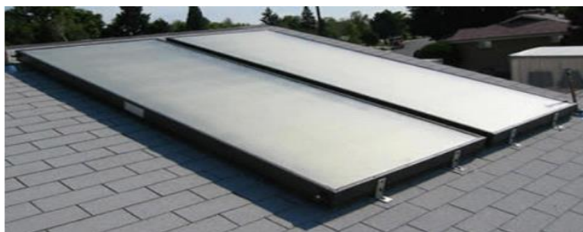
Figura 5.2. Foto de un colector de placa plana con cubierta. Fuente: http://www.inti.gob.ar/e-renova/pdf/colectores_solares_aguacaliente.pdf
