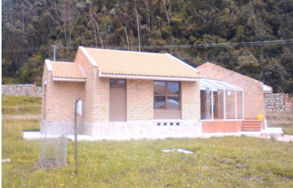
Imagen 2. Vivienda de ladrillo y acero
