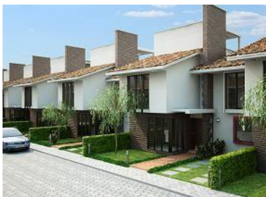
Imagen 11. Condominio Horizontal Fuente: Wordpress, (2008)
