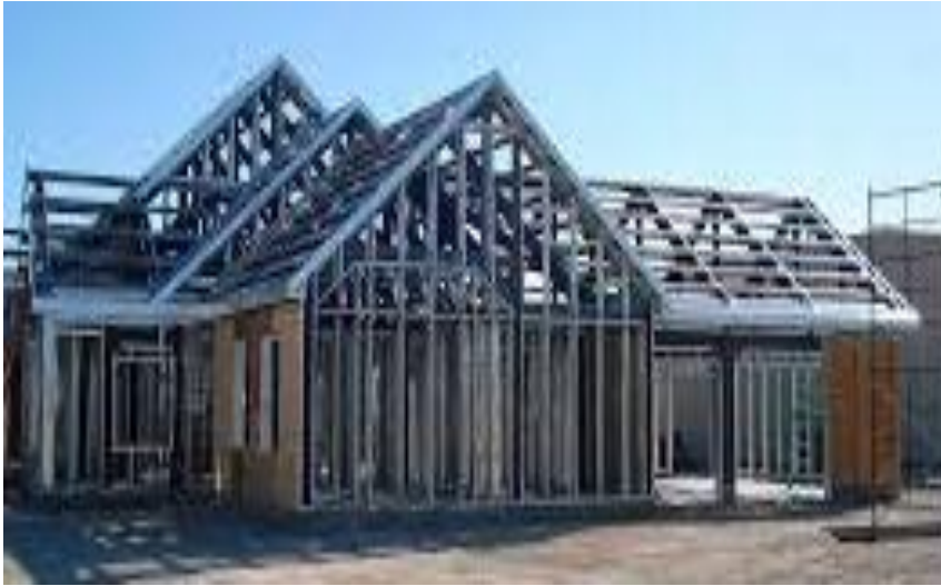
Imagen 4. Vivienda en acero Fuente: ZORRILLA, Héctor (2013)
