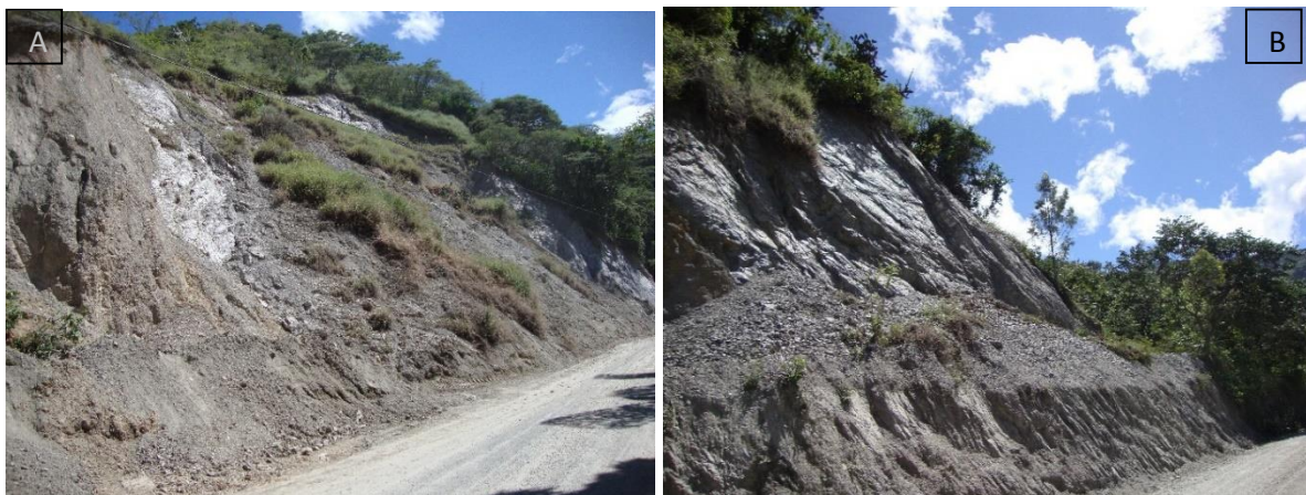
Fotografía 4. 9 Orientación desfavorable de discontinuidades en la Unidad Chiguinda. A) Sector Sacapo MI-26. B) Sector Sacapo MI-27. Fuente: Abarca, 2014.
