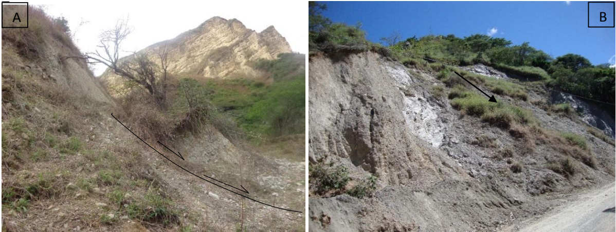
Fotografía 4. 1 Deslizamientos: A) Deslizamiento rotacional en movimiento complejo, sector linderos (MI-32). B) Deslizamiento traslacional, barrio Sacapo (MI-26). Fuente: Abarca, 2014.
