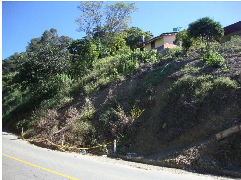
Fotografía 4. 12 Carga en la corona de talud, MI-15. Fuente: Abarca, 2014.
