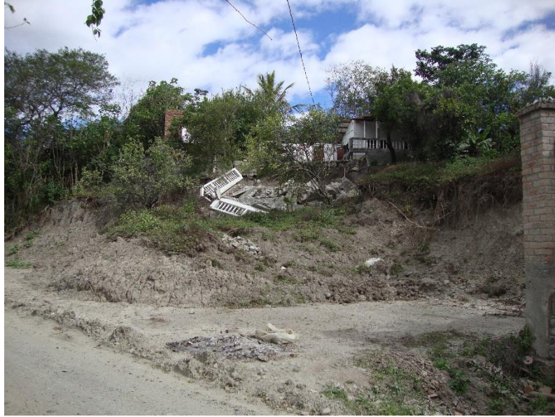
Fotografía 4. 11 Corte en la pata del talud, MI-28. Fuente: Abarca, 2014.
