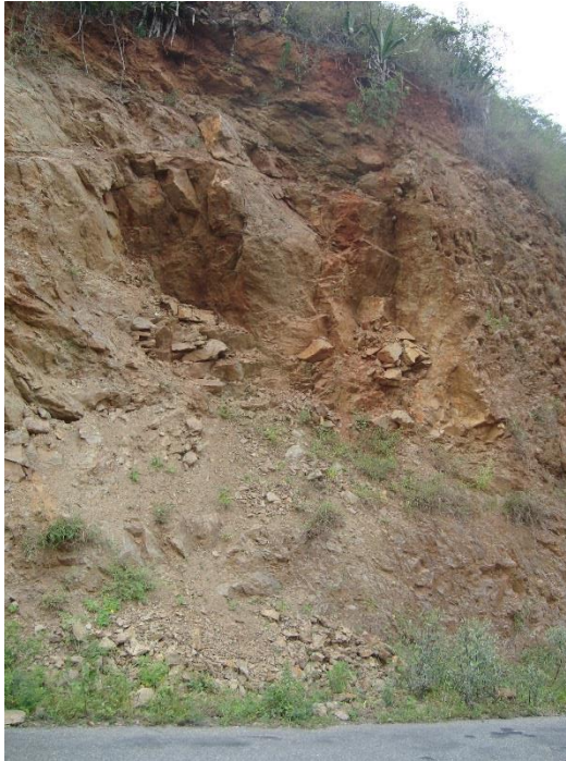
Fotografía 4. 4 Movimiento de ladera tipo caída de rocas, sector Linderos. Fuente: Abarca, 2014.
