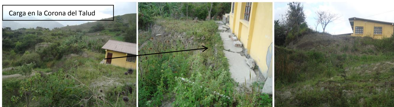
Foto 4. 12 Carga en la Corona del Talud, movimiento rotacional (ML-10). Fuente: Carrillo, 2014.
