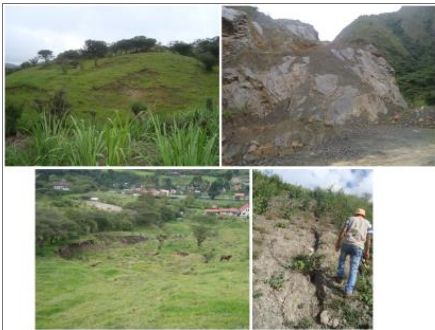
Foto 4. 10 Material fisurado, agrietado y meteorizado. Fuente: Carrillo, 2014.
