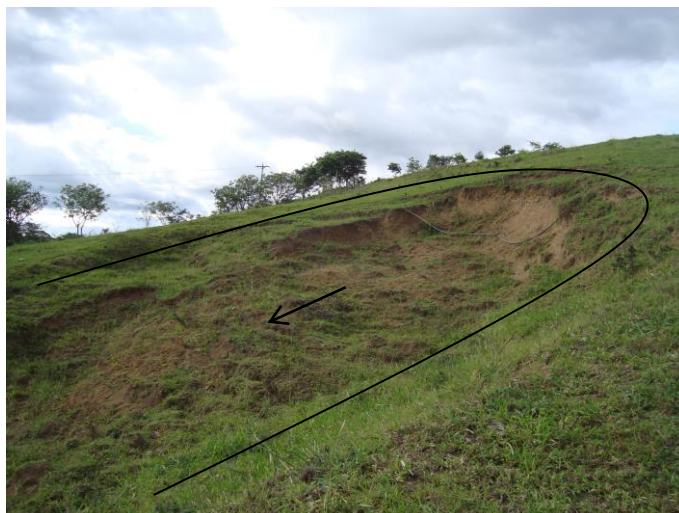
Foto 4. 14 Deslizamiento Rotacional (ML-55) en suelo arcilloso, producto de las lluvias en los meses de febrero del 2014.
