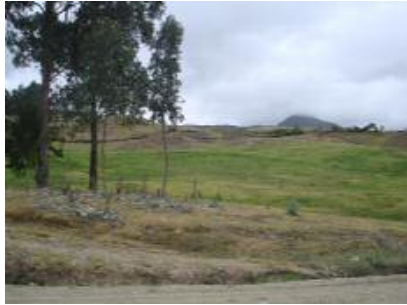
DESLIZAMIENTO EN LA AV. INTEGRACION BARRIAL EN EL SECTOR MENFIS CENTRAL
