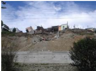
DESLIZAMIENTO EN LA AV. MANUEL CARRION P. Y QUINARA PRODUCIDO POR ACTIVIDAD ANTROPICA
