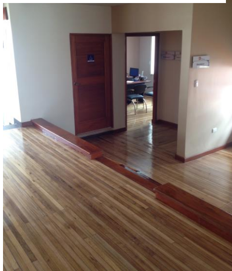
FOTOGRAFIA 18 SEGUNDO PISO EDIFICIO 1 ZALA DE ESPERA
