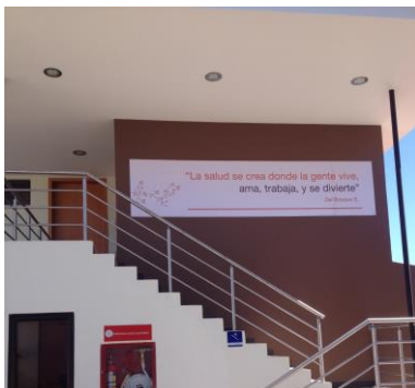
FOTOGRAFIA 14 EDIFICIO 1 ZONA LATERAL REHABILITADA
