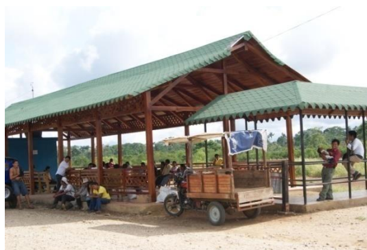
Terminal Aéreo. Ciudad de Taisha
