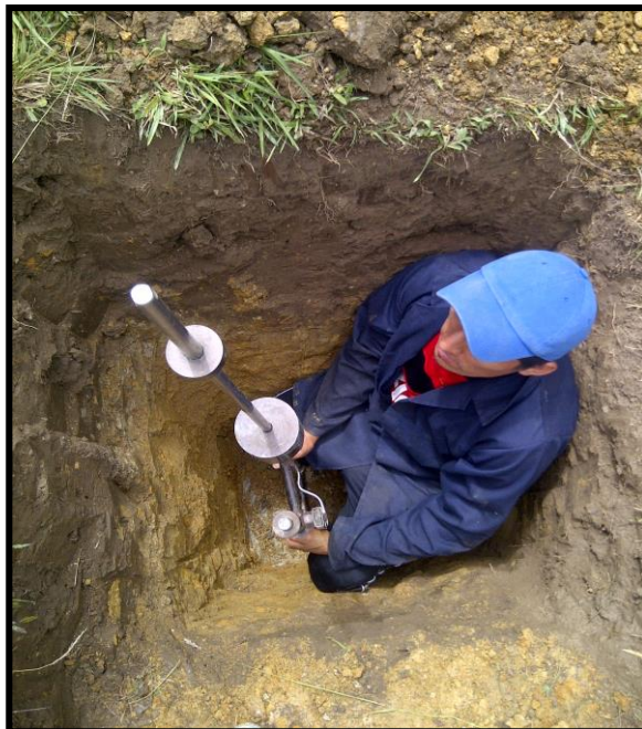
Fotografía 2: Ensayo de (DCP).
