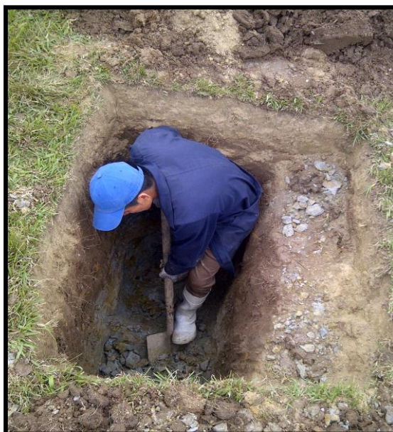
Fotografía 4: Proceso de la excavación a cielo abierto y obtención de la muestra alterada.
