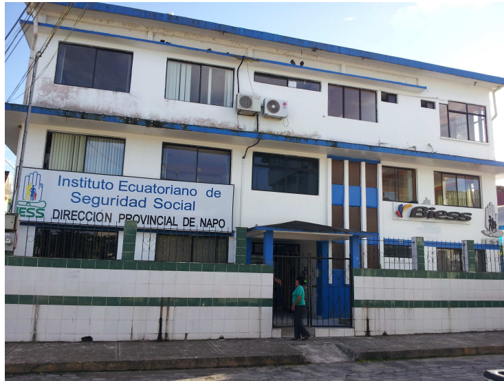
Figura 4. Vista actual de la Dirección Provincial IESS Napo Fuente: Toma propia
