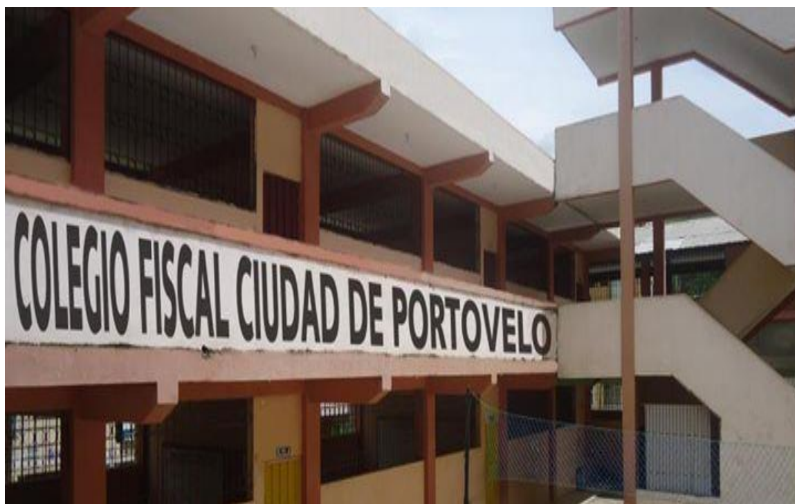
Instalaciones del Colegio de Bachillerato "Ciudad de Portovelo"
