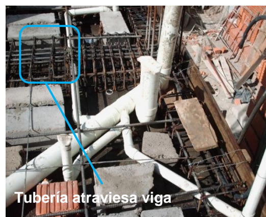
Grafico 32 Colocación de Tubería Hidro-Sanitaria
