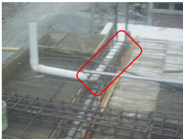
Fotografía de vivienda en construcción, trabajo de clase de la materia Construcciones IV (Mayo 2008) Tomada por el autor.
