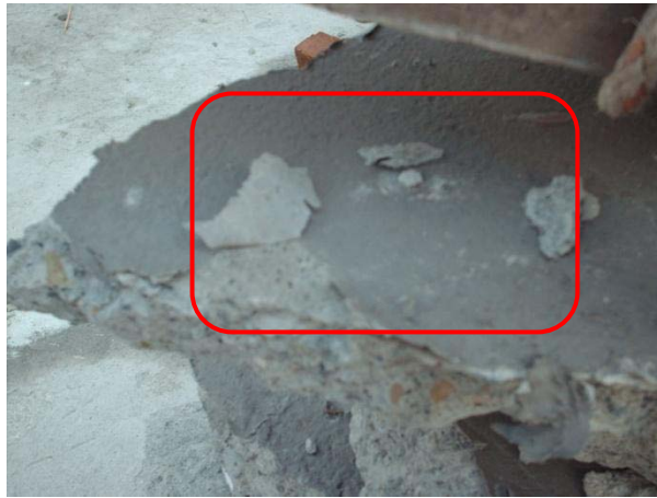
Fotografía vivienda Sra. Betty Rodriguez, Terraza construida con el Sistema M-2 (Enero 2010), Tomada por el autor.
