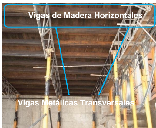
Grafico 31 Encofrado para losa
