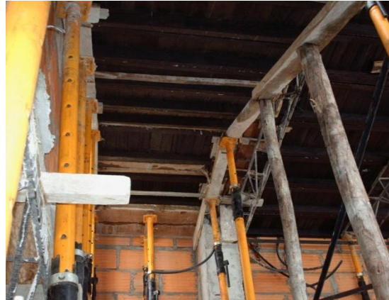
Grafico 30 Encofrado para gradas
