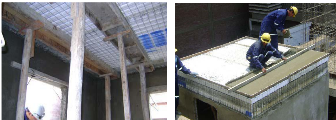
Grafico 19 Colocación del hormigón en la losa
