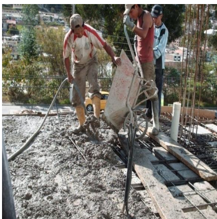
Grafico 36 Mezclado del Hormigón
