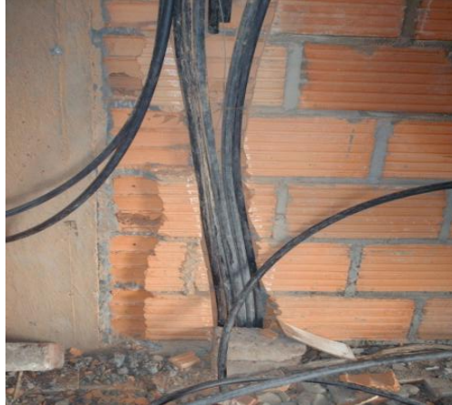
Grafico 26 Colocación del cableado eléctrico
