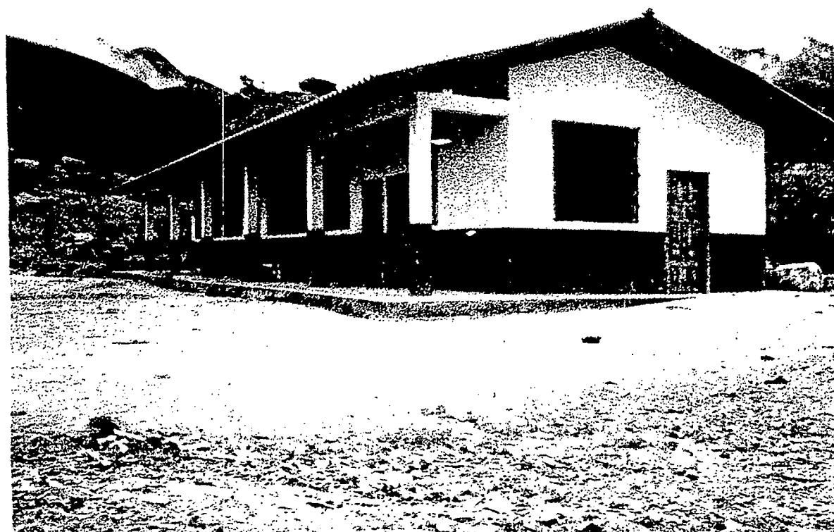
DESPUES. Escuela actual construida por EL AN INTERNACIONAL en la comunidad de Chayapa. Compuesta de fierro, hormigon armado y cemento, además cuenta con una cocina, implementada con los servicios necesarios.
