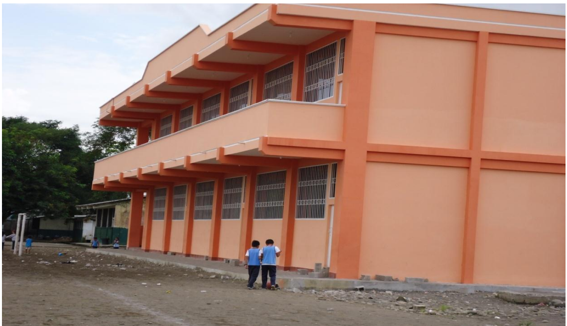
Foto 2: Bloque de aulas
