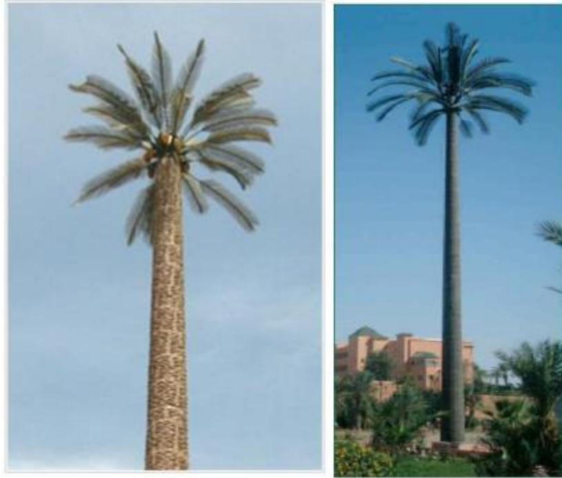
Figura 0.3 Torre camuflada estilo palmera con cocos. Fuente: [1]
