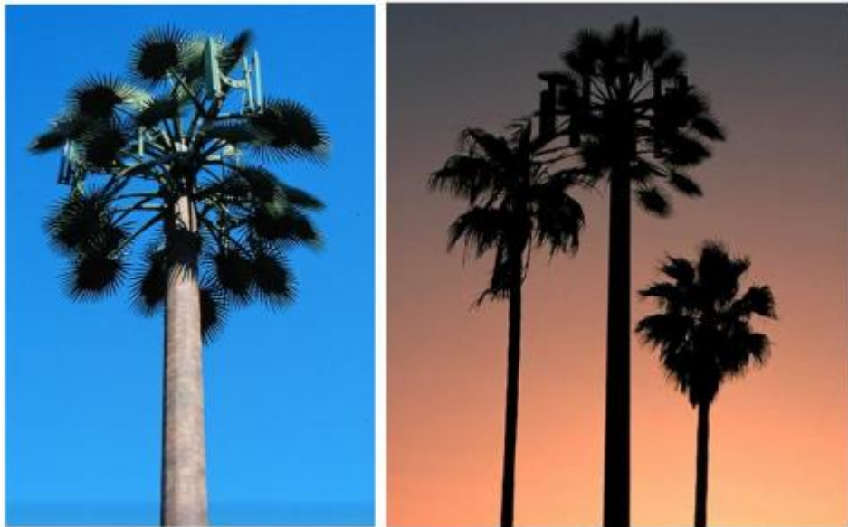
Figura 0.2 Torres camufladas estilo palmera. Fuente: [1]
