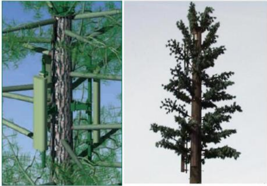
Figura 0.1 Montaje de equipos en torres estilo pino. Fuente: [1]
