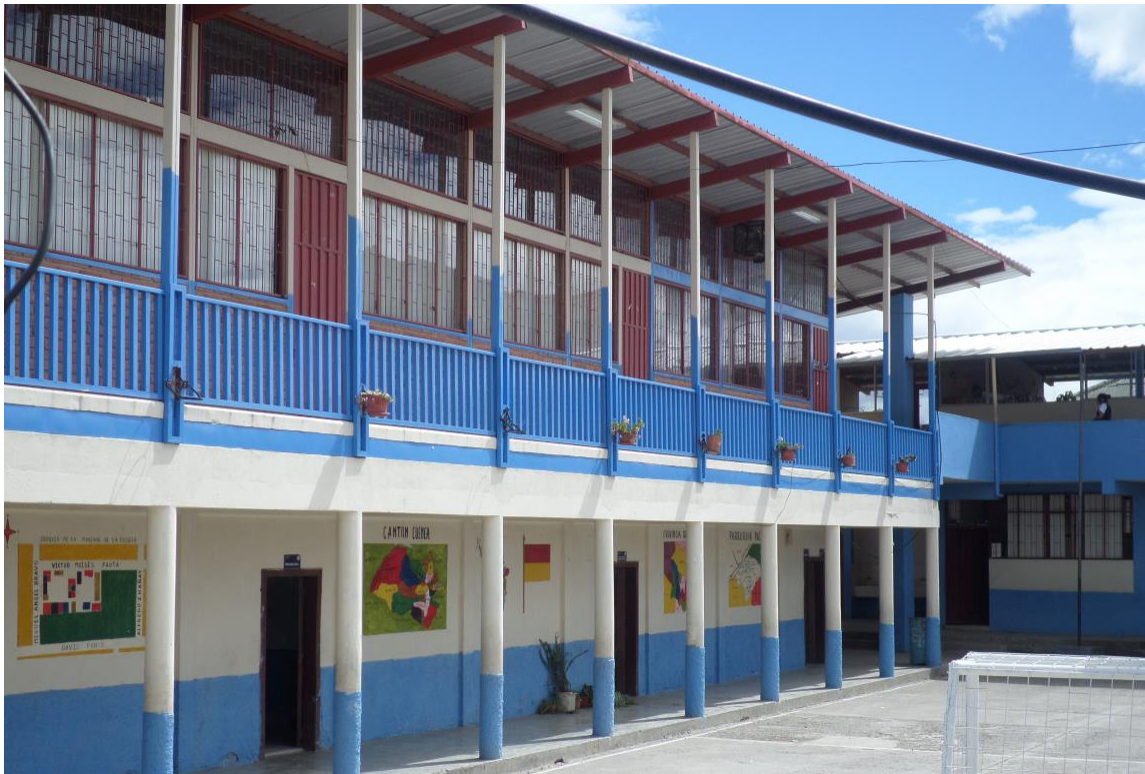
Fotografía 3. Aulas de la Unidad Educativa Paccha
