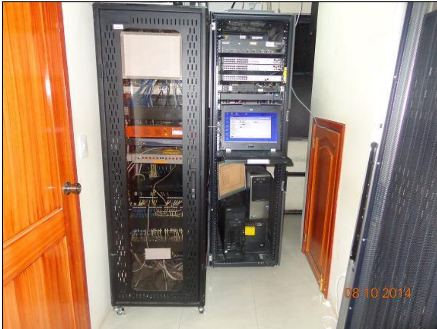
Gráfico 71. Armarios de Comunicaciones y Servidores
