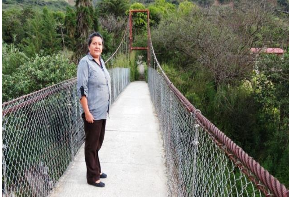
FOTOGRAFÍA No. 13: Puente colgante, barrio El Chaupi
