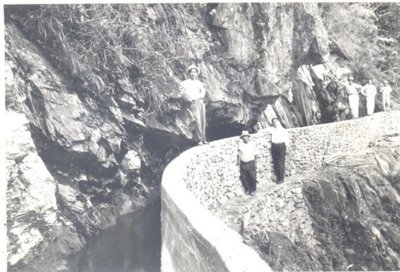
FOTOGRAFÍA No. 2: Construcción del Canal de Riego "Canal Alto"
