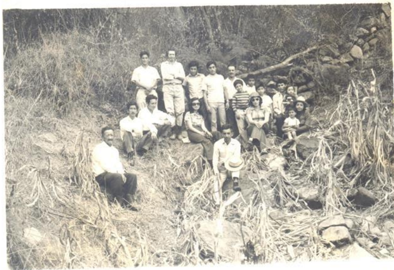
FOTOGRAFÍA No. 6: Habitantes que ayudaron a la construcción del Canal de Riego “Canal Alto”
