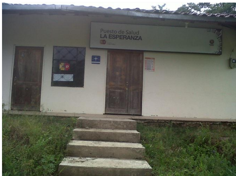
Figura 3. Puesto de Salud La Esperanza. Se encontraba cerrado al momento de la visita.
