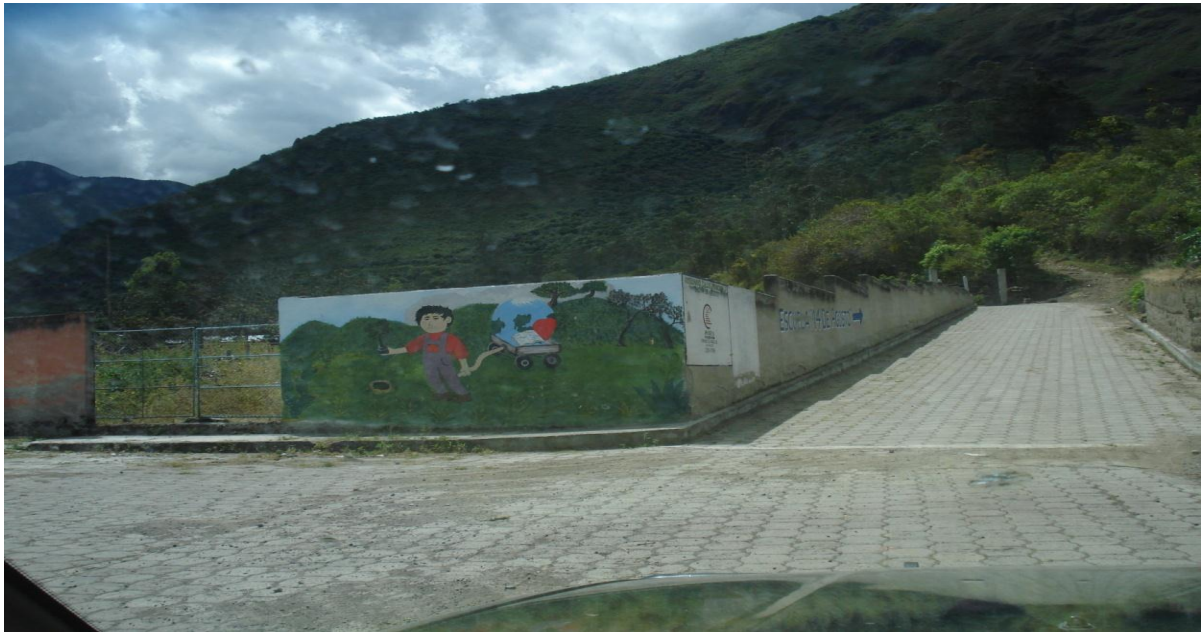
Escuela "14 de Agosto" ubicada en área rural de la Parroquia Juan Montalvo, cantón Mira, provincia del Carchi.
