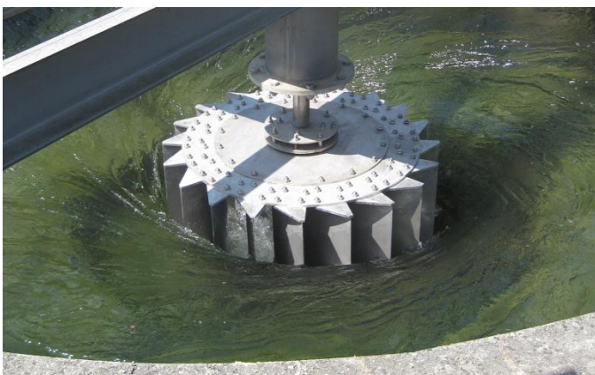
Fig. 19. Vista panorámica de una turbina Zotlöterer en funcionamiento [32].
