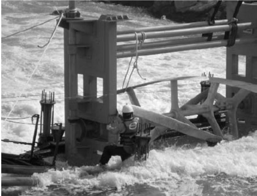
Figura 2.4. Microcentral hidroeléctrica equipada con una turbina Gorlov
