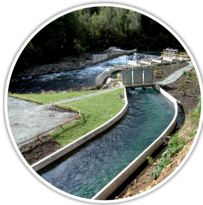
Figura 3.2. Infraestructura de captación de agua para su posterior utilización en microcentrales hidroeléctricas
