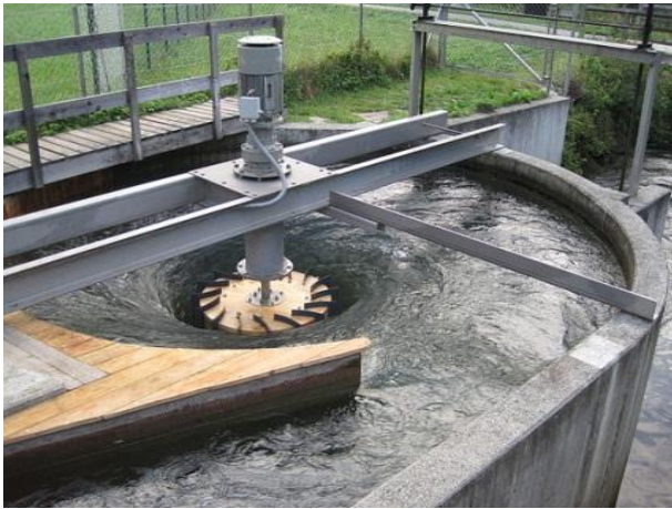
Fig. 6. Microcentral hidroeléctrica basada en vórtice gravitacional [17].
