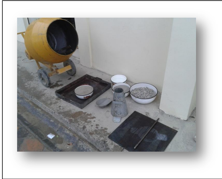
Figura Anexo 9. 7 Materiales y equipos para realizar la mezcla de concreto
