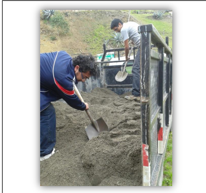
Figura Anexo 9. 3 Árido fino descargado para ser ingresado a lugar de acopio.
