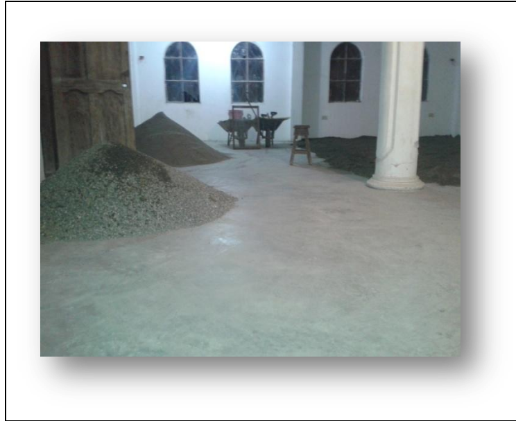
Figura Anexo 9. 5 Árido fino y grueso en lugar de acopio
