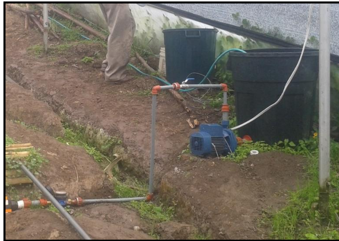
Figura 27. Tanques de reserva cónicos Fuente. El autor Elaboración. El autor, 2015..
