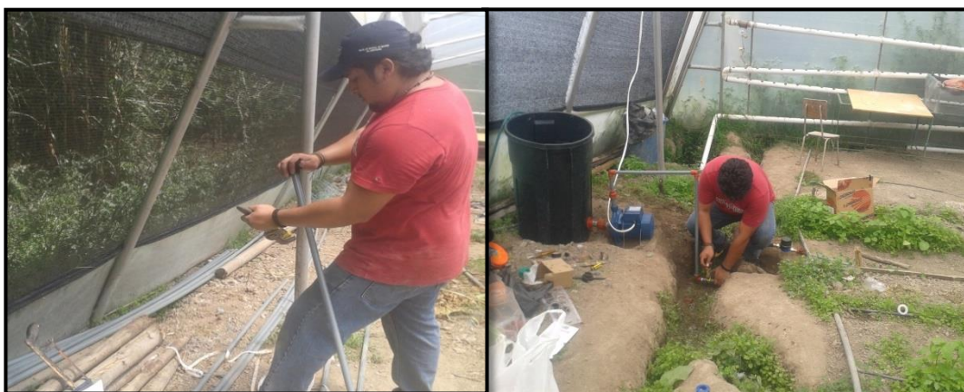
Figura 37. Instalación de la red de riego para toma de datos de campo. Fuente. El autor. Elaboración. El autor, 2015.
