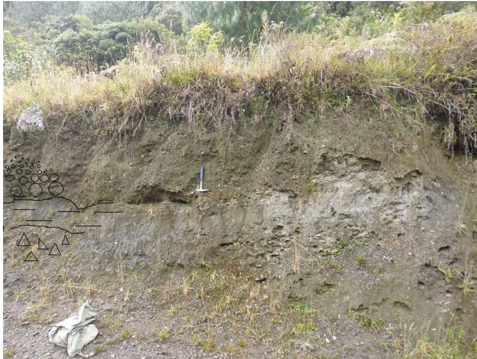
Fotografía 86. Depósito aluvial estratificado del afloramiento del Punto 296. Fuente: El autor.
