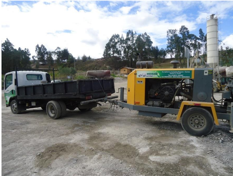
Imagen 12. Camión y bomba de impulso Fuente: Hormi - Center Elaborado por: Autor
