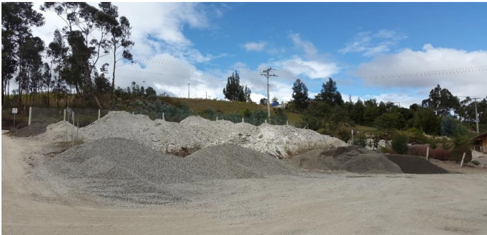
Imagen 7. Almacenamiento de materiales Fuente: Hormi - Center Elaborado por: Autor
