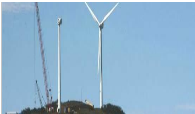
Ilustración 2. Instalación eólica de San Cristóbal
