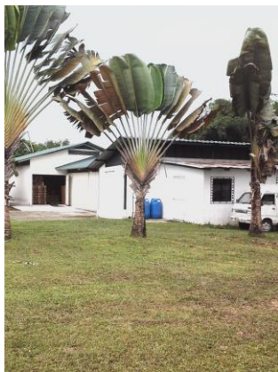
Figura 1: Instalaciones general Fuente: Granen Ecuador Elaborado por: Iván Ramírez
