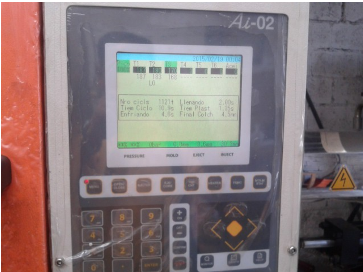
CHILLER Y COMPRESOR ENFRIADOR POR AGUA
