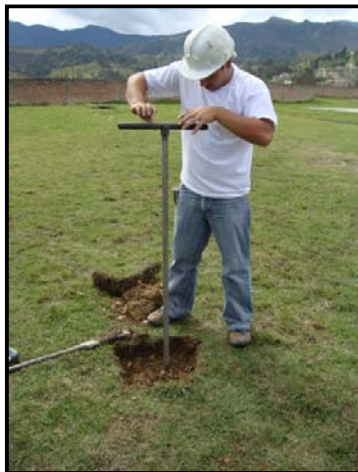
Figura 3.4 Perforación con posteadora. Fuente: La autora
