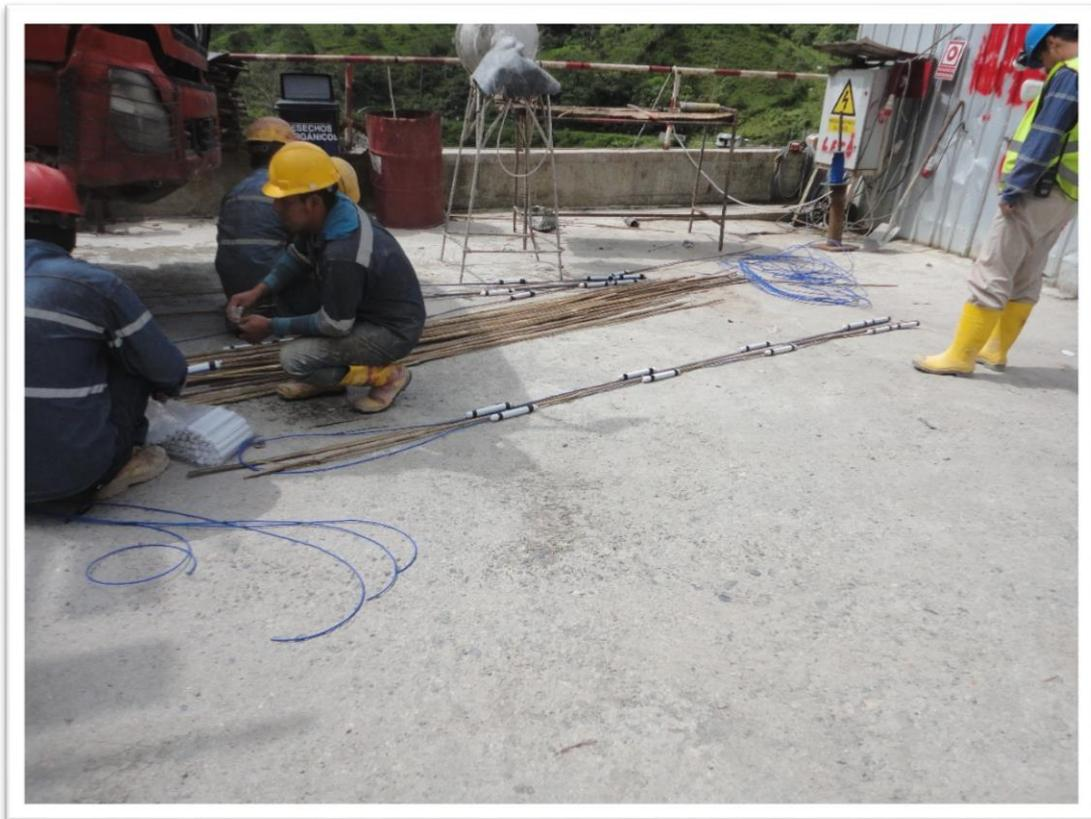
**Figura 4.11:** Diseño de carga para línea de taladros de pre corte en las excavaciones subterráneas
