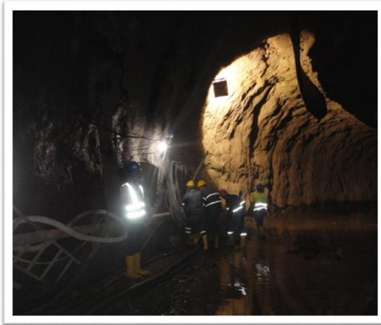
**Figura 4.21:** Perfil de excavación con sostenimiento pesado en túnel subhorizontal, se observa cerchas, malla y pernos revestidos con hormigón lanzado.
