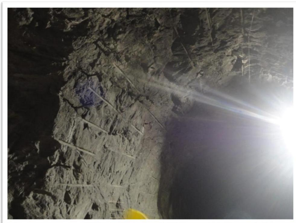
**Figura 4.13:** Aspecto de bóveda del túnel de carga después de voladura controlada, se observan las medias cañas de los taladros.
