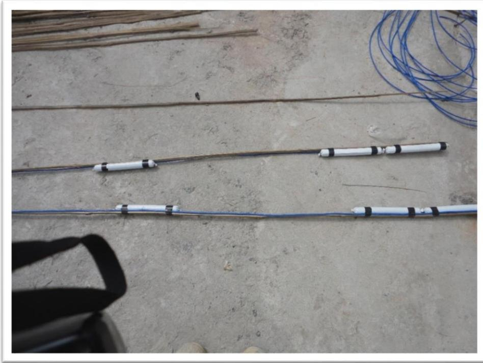
**Figura 4.12:** Cargas de emulsión especiales para macizo rocoso mojado, espaciadas para disminuir la presión dentro del taladro en línea de pre-corte.
