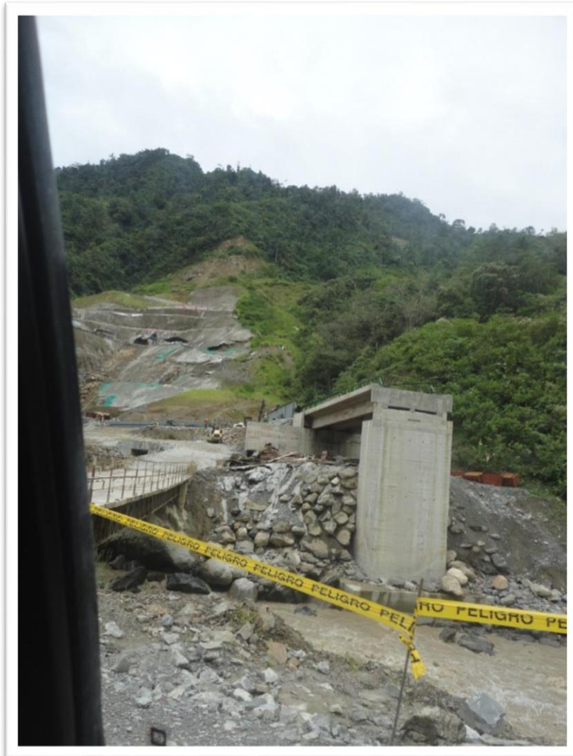
**Figura 4.14:** Imagen escala donde se observa el emboquille del túnel subhorizontal y su carga litostática.
