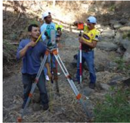
Ubicación de equipo estación total en la sección de cierre Celica – Bramaderos
