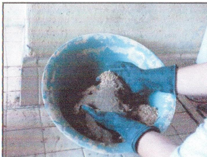
**Figura 4.8** Mezclado de arcilla con aserrín
