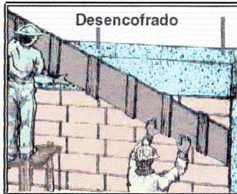
Figura 7.9 Desencofrado de las vigas de confinamiento
