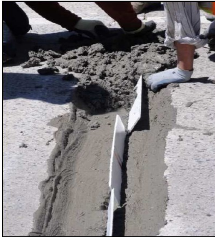
Figura 25. Reconstrucción de juntas.
