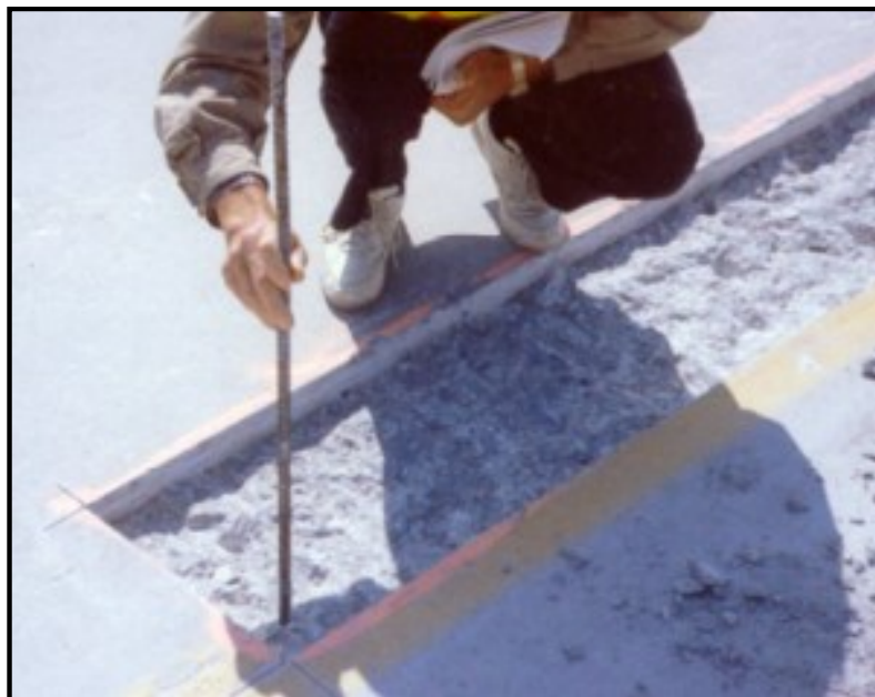
Figura 24. Aspecto de una reparación parcial aserrada y picada.
