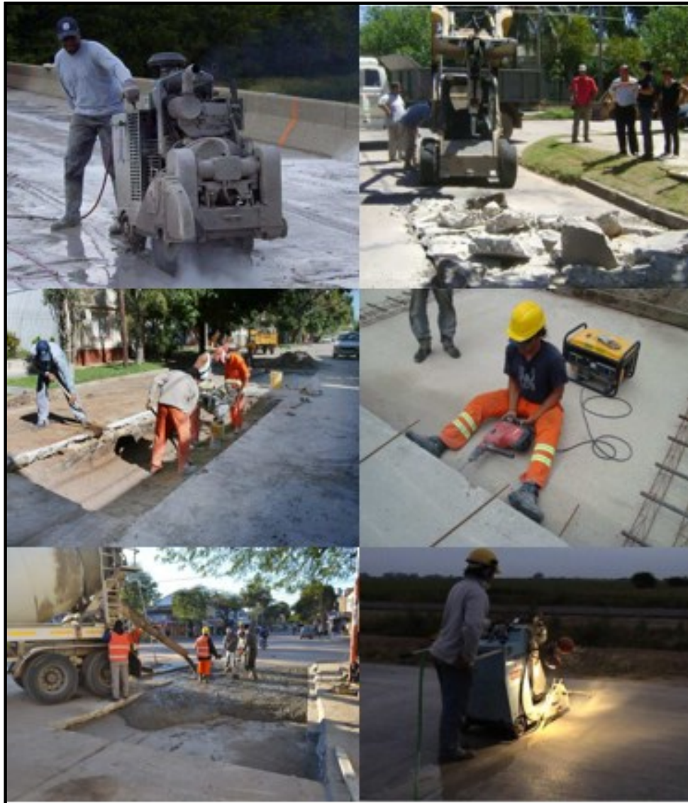
Figura 27. Proceso de parcheo profundo.
