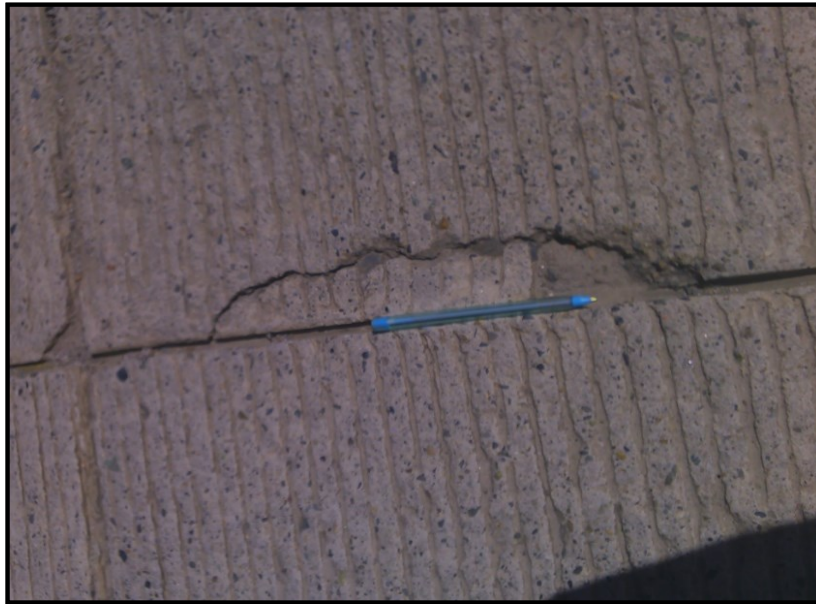
Figura 18. Descascaramiento de junta de severidad baja (Vía Loja - Zamora). (Abscisa 2+238.60)
