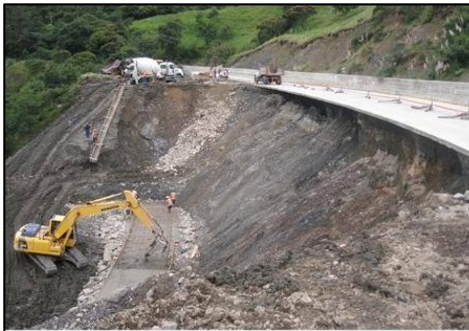
Figura 4. Construcción de muro de contención Km 7.
