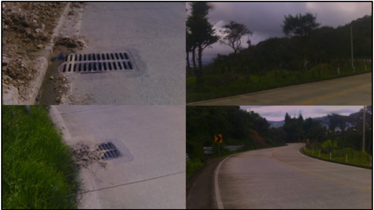
Figura 3. Vegetación y drenajes a lo largo de la vía.
