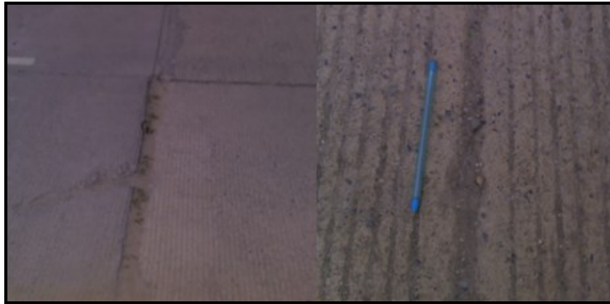
Figura 19. Crecimiento de vegetación y suelo en la junta (Vía Loja - Zamora). (Abscisa 0+746.20)
