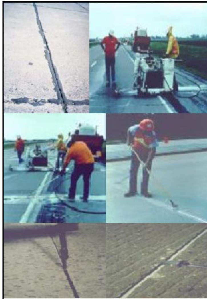
Figura 26. Proceso de resellado de juntas y sellado de grietas.
