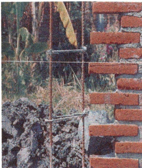
**Figura 8.2.** Detalle de columna de confinamiento en obra.
