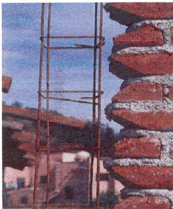
**Figura 8.3.** Detalle de columna de confinamiento en obra.
