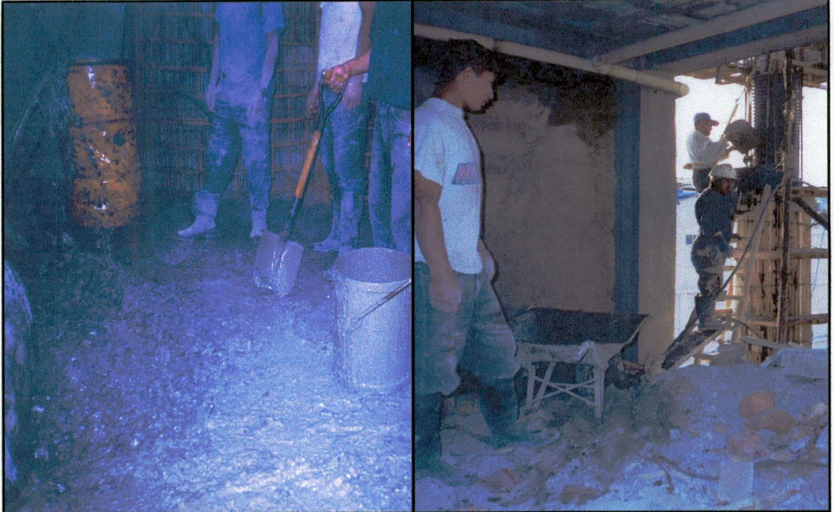
Producción y colocación de hormigón en columnas
