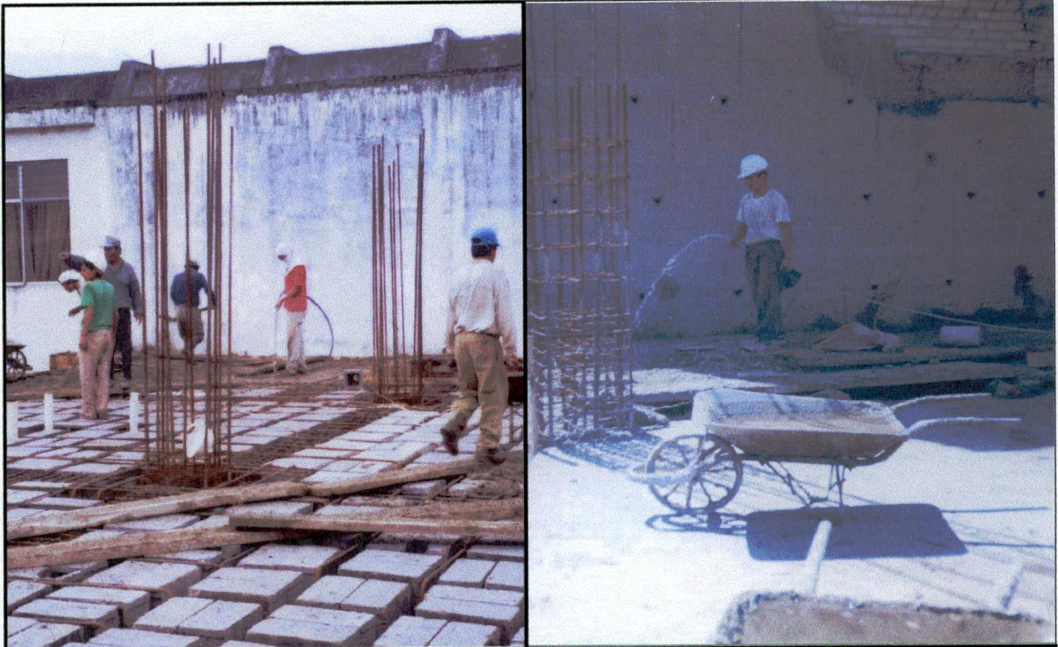
Vibrado y curado del hormigón
