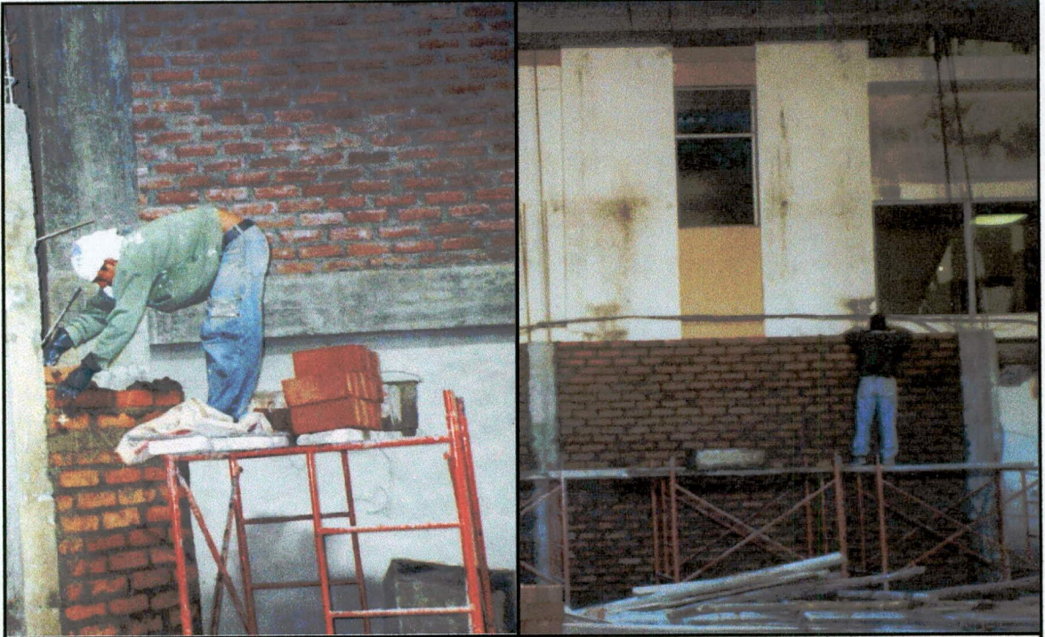
Mampostería de ladrillo
