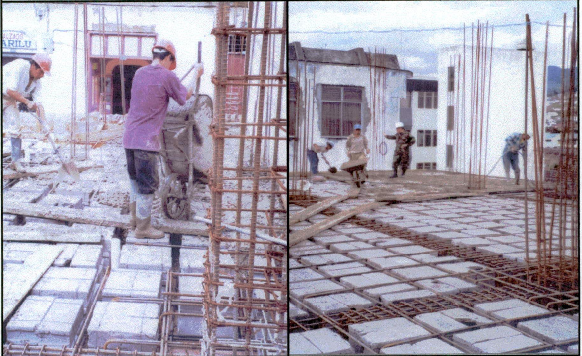
Colocación de hormigón en losas
