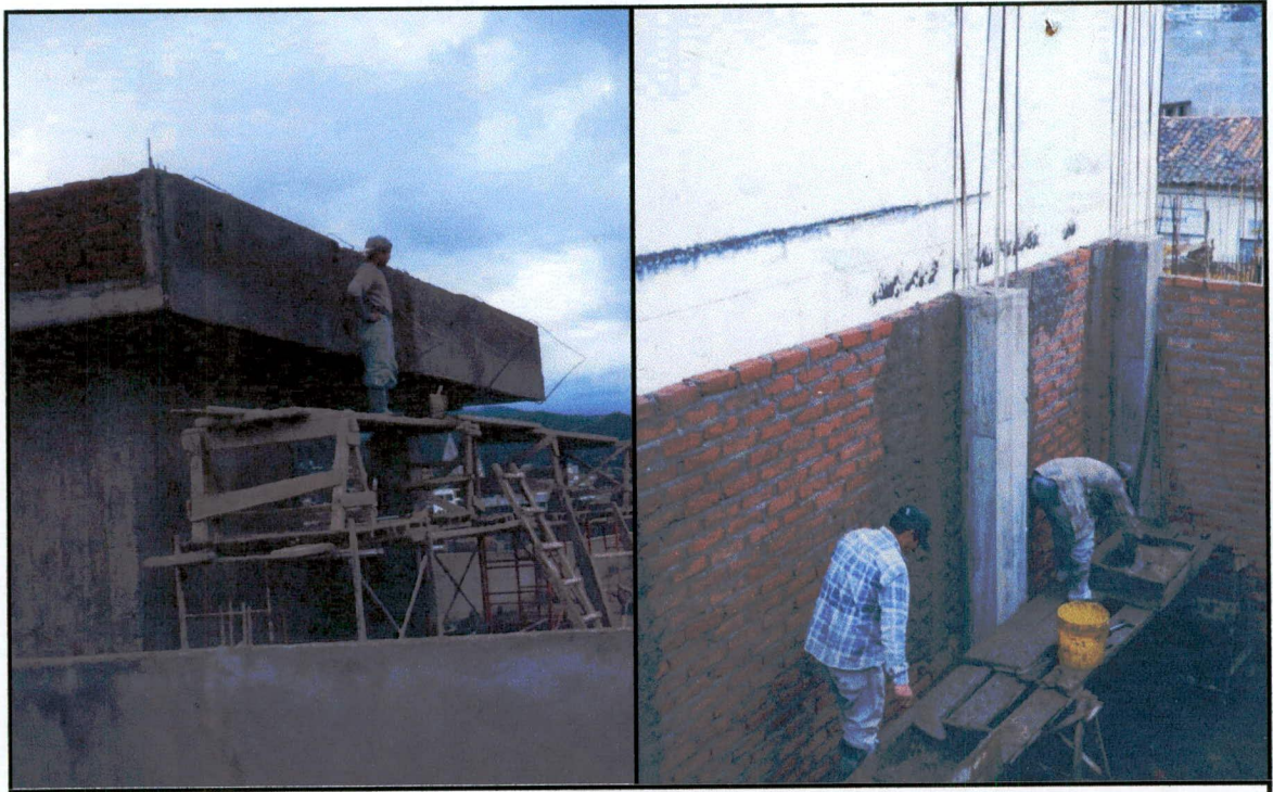
Enlucido con mortero 1:3
