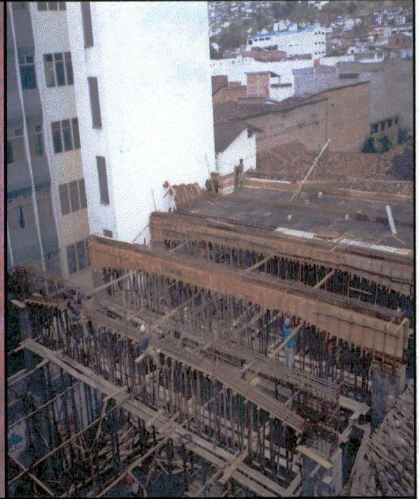
Encofrado, armado de losa de cubierta en edificio auditorio
