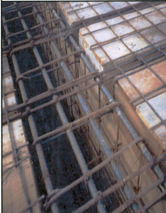
Encofrado, armado y alivianamientos en losa de cubierta piso en edificio auditorio
