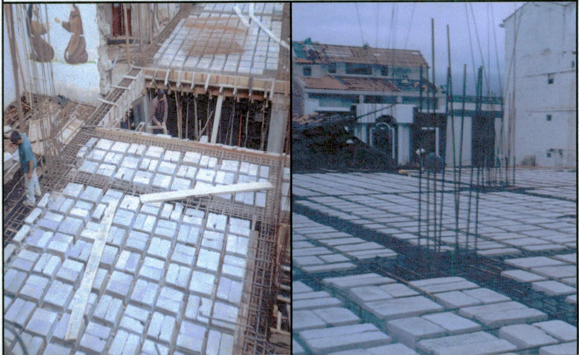
Encofrado, armado y alivianamientos en losas de entre piso en edificio administrativo
