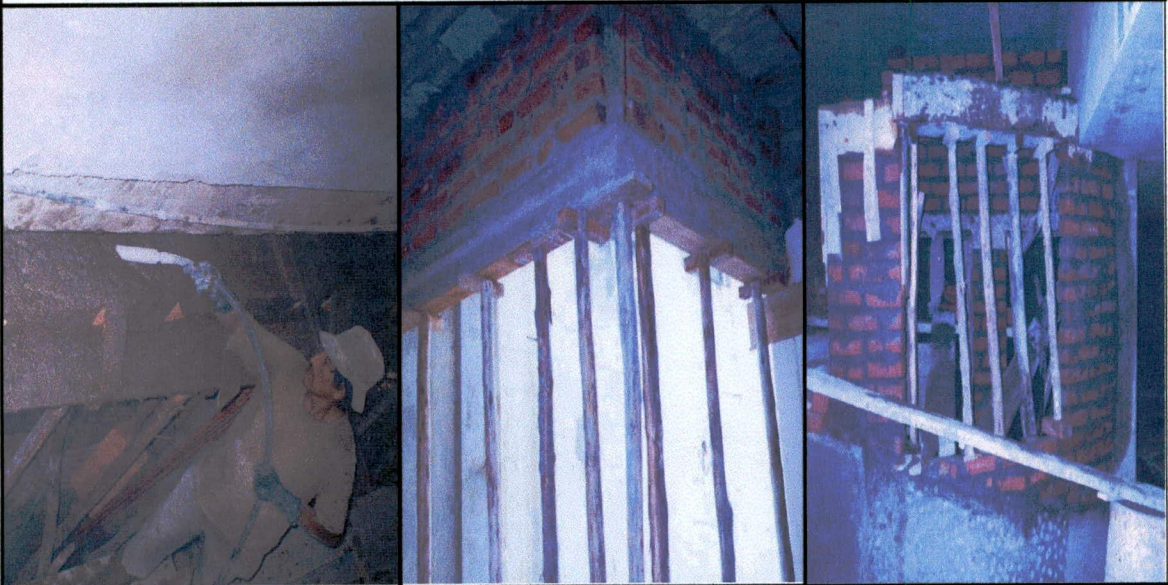
Encofrado y hormigonado de dinteles
