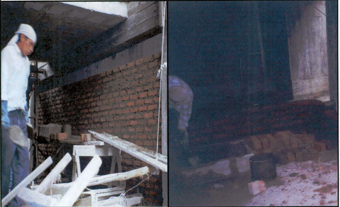
Mampostería de ladrillo
