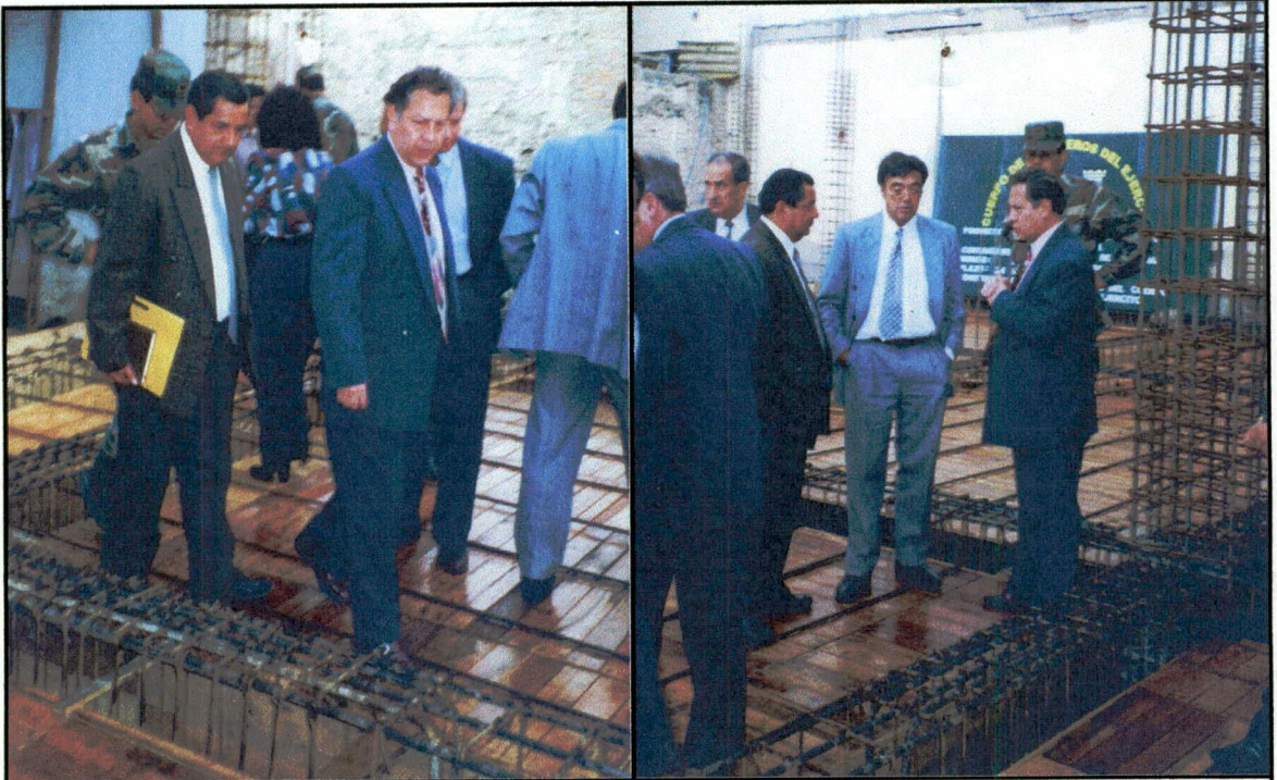
Visitas de inspección a la obra, estas se realizan con la presencia de la fiscalización, los constructores, y de ser el caso con las autoridades de la Corte Suprema de Justicia y Consejo Nacional de la Judicatura
