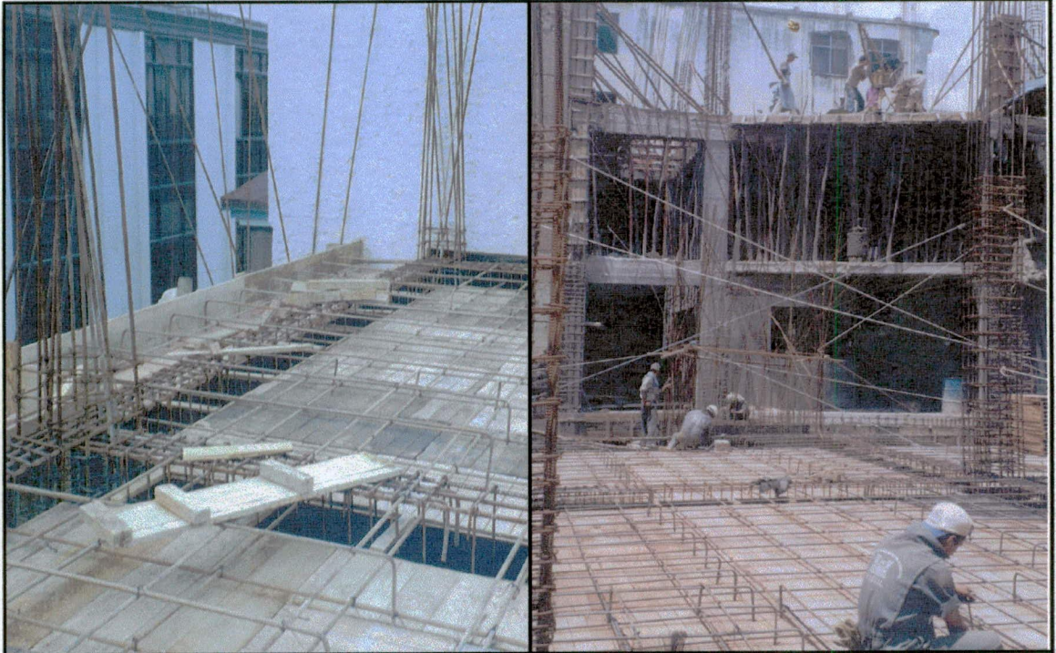
Encofrado y armado de losas de entre piso en edificio administrativo
