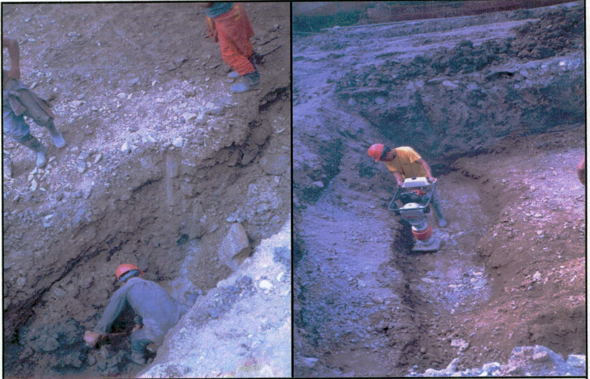
Relleno y compactación
