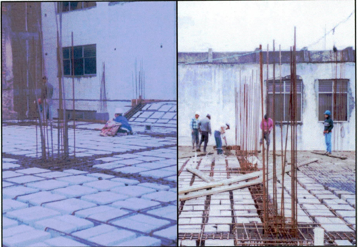
Control de cantidades de obra y procesos constructivos
