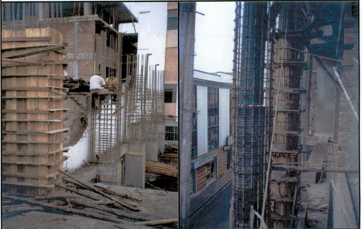
Encofrado y armado de columnas
