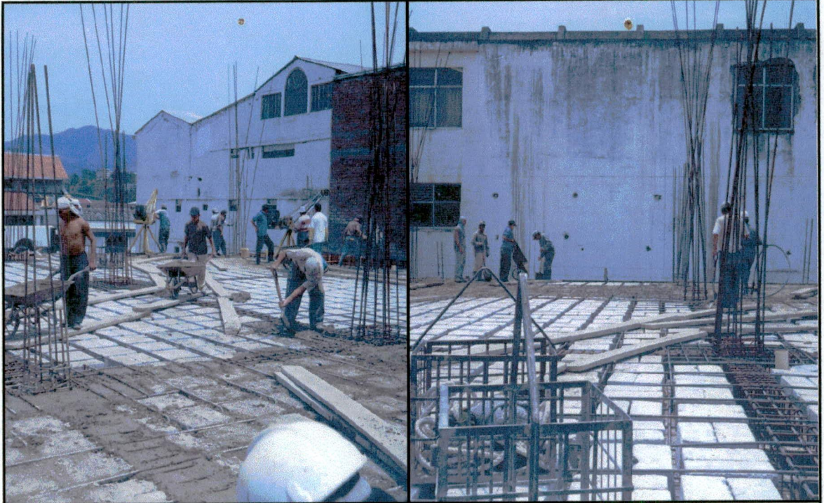
Colocación de hormigón en losas
