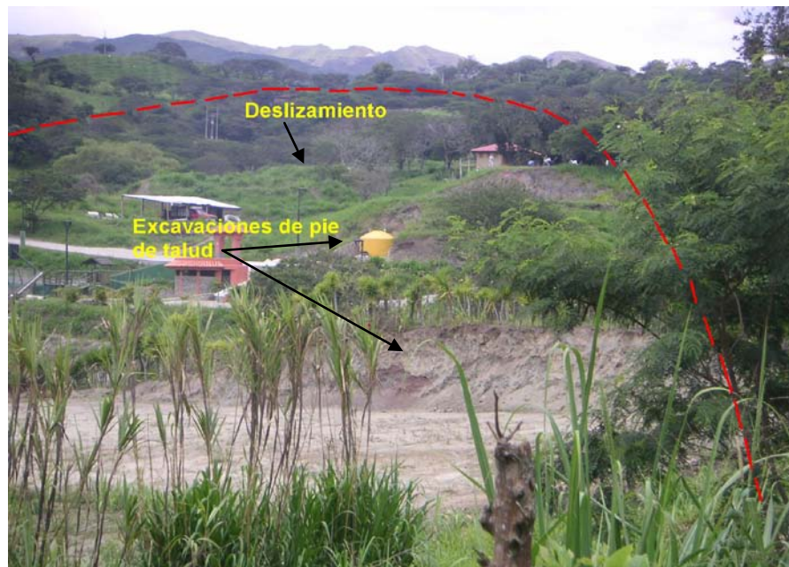
Foto 29: Deslizamiento producido por corte de vía
