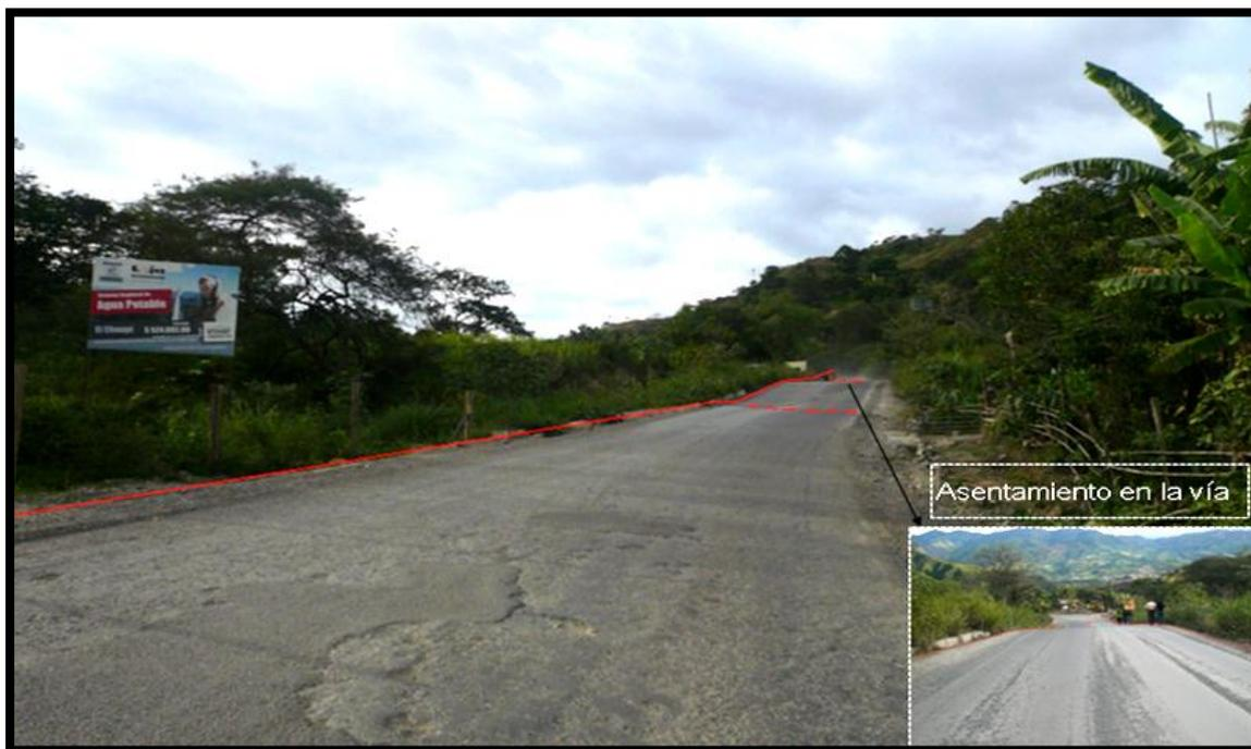
*Figura 12. Asentamiento en vía Malacatos – Vilcabamba, producto del deslizamiento.*
