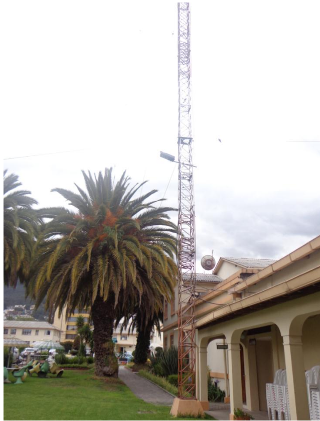
Figura 27: Antena para transmisión actual
