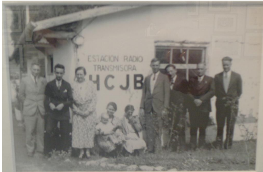
Figura 23: Primeras instalaciones de Radio HCJB
