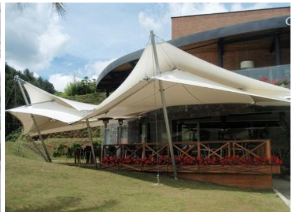
Imagen: C3 – 31 Cubierta con lona vinílica
