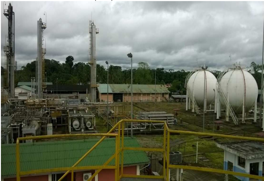
Figura 3 Ubicación de la planta de gas en la Refinería Shushufindi Fuente: EP PETROECUADOR (2015)
