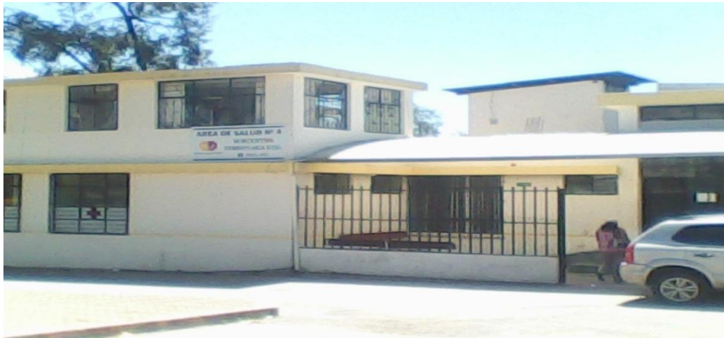
Figura 10: Centro de Salud ferroviaria Baja
