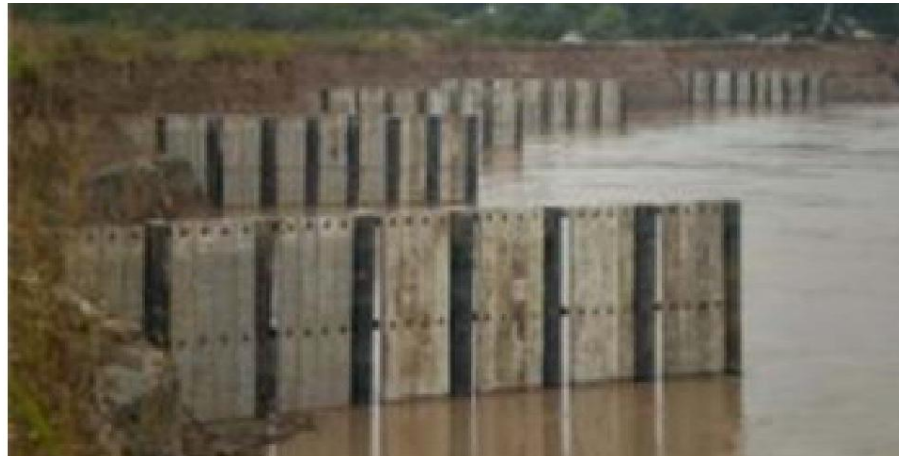
Figura: 2.3 Espigones formados por pilotes metálicos,
